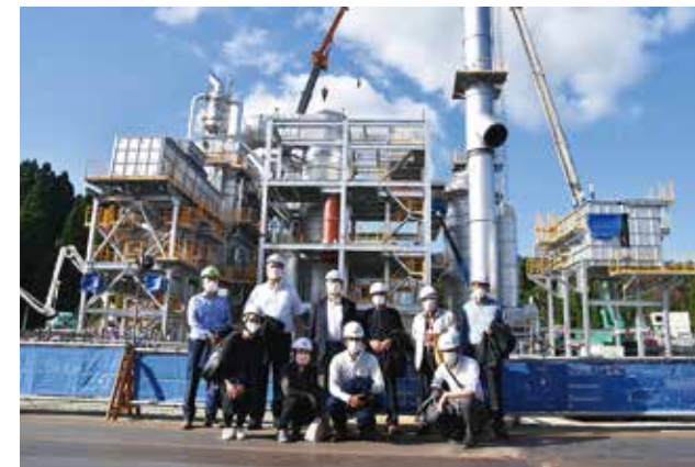
建設中の新焼却炉前にて
